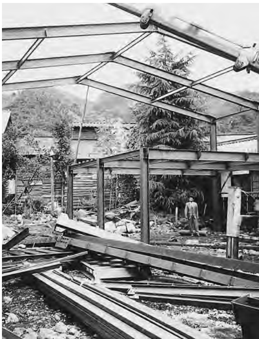
柳田建材部店舗工事（5月～7月）
