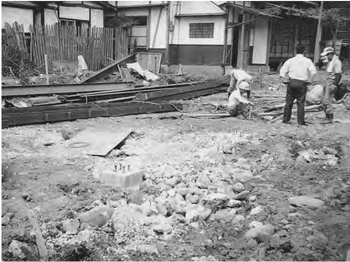
柳田建材部店舗工事（昭和41年5月27日から着工）
